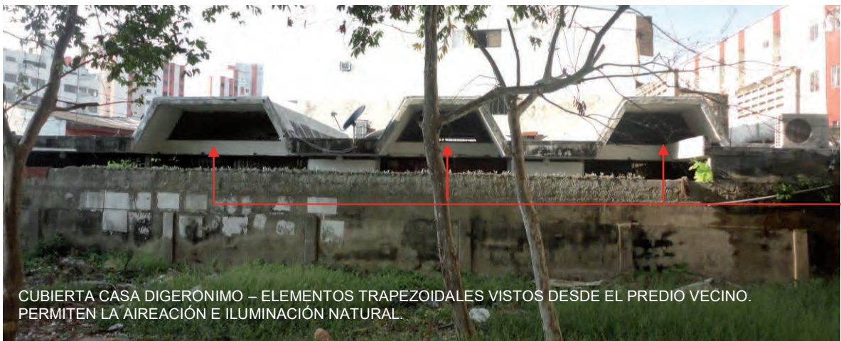
Imagen 135: 2016. Casa Digeronimo, plano localización tomada del IGAC y del MIDAS. Se observan las pérgolas en la fachada principal y los tres trapecios de concreto en la parte superior de la cubierta, los cuales permiten la aireación, ventilación e iluminación natural de la casa. Fuente: Archivo personal, 2013.
