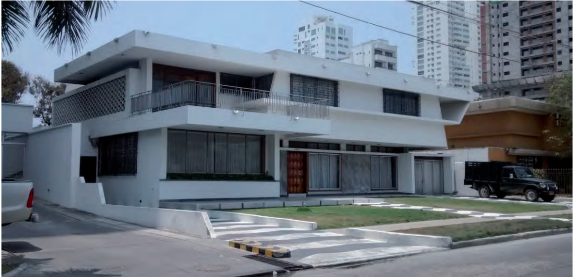
Imagen 243: Casa Barbur en Castillogrande. Manejo formal y volumétrico, jerarquía de accesos, retranqueos de planos para mitigación de la incidencia solar, terrazas amplias y vanos de ventanas abiertos a las vistas (bahía de Cartagena), aleros, calados, ventilación e iluminación natural superior, antejardín sin cerramiento, aislamientos laterales, patio posterior, cubierta plana, etc. Fuente: Archivo personal, 2016.
