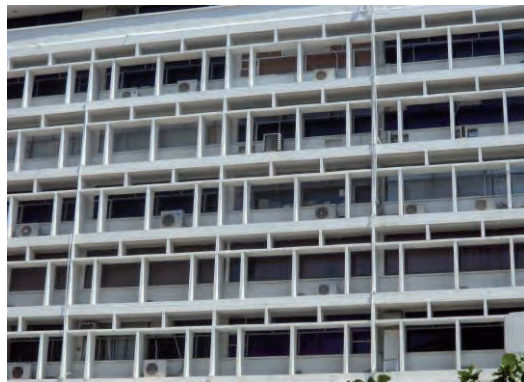
Imagen 226: Edificio Banco de Bogotá. Fachada falsa reticulada para protección del sol de la mañana implementada con quebra soles, corta soles, persianas verticales, retranqueos, etc. Fuente: Archivo personal 2016.
