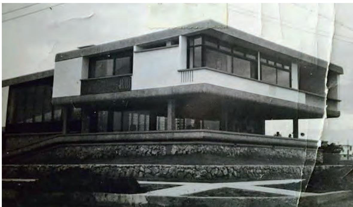
Imagen 118: Casa Barker, edificación de impactante manejo volumétrico que desarrolla planta libre (terrace social en esquina), con retrocesos de vanos, cubierta plana en concreto y terraza balcón en la segunda planta, fachadas vidriadas, etc. Fuente: fotografía tomada del Facebook del arquitecto Fernando Lemaitre. Publicada el día 19 de agosto de 2015. Cortesía de Stephen Barker.
