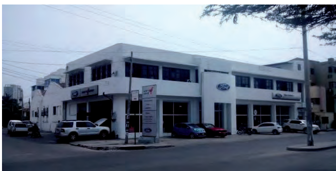
Imagen 131: 2016. Edificio Noel en la actualidad. Los balcones han sido cubiertos con Drywall y se le agrega en el mismo material un pórtico en el acceso. Fuente: Archivo personal.
