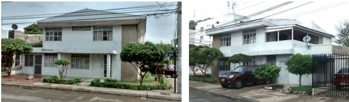
Imagen 138: Fachada Principal sobre el Camino Arriba o calle 29 D en el Pie de la Popa y fachada lateral sobre el callejón del Albercón. Fuente: Archivo personal. | 2016.
