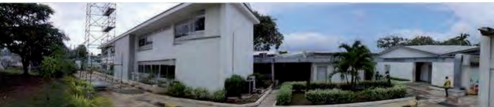
Imagen 324: Fotografías del edificio del Sena. Se observan las nuevas ventanas en aluminio que le fueron colocadas a los bloques administrativos y de la biblioteca. También apreciamos en esta última, la ampliación del administrativo hacia el costado sur que adopta la forma longitudinal y cubierta abovedada paramentando la avenida del Consulado. Fuente: Archivo personal 2015.
