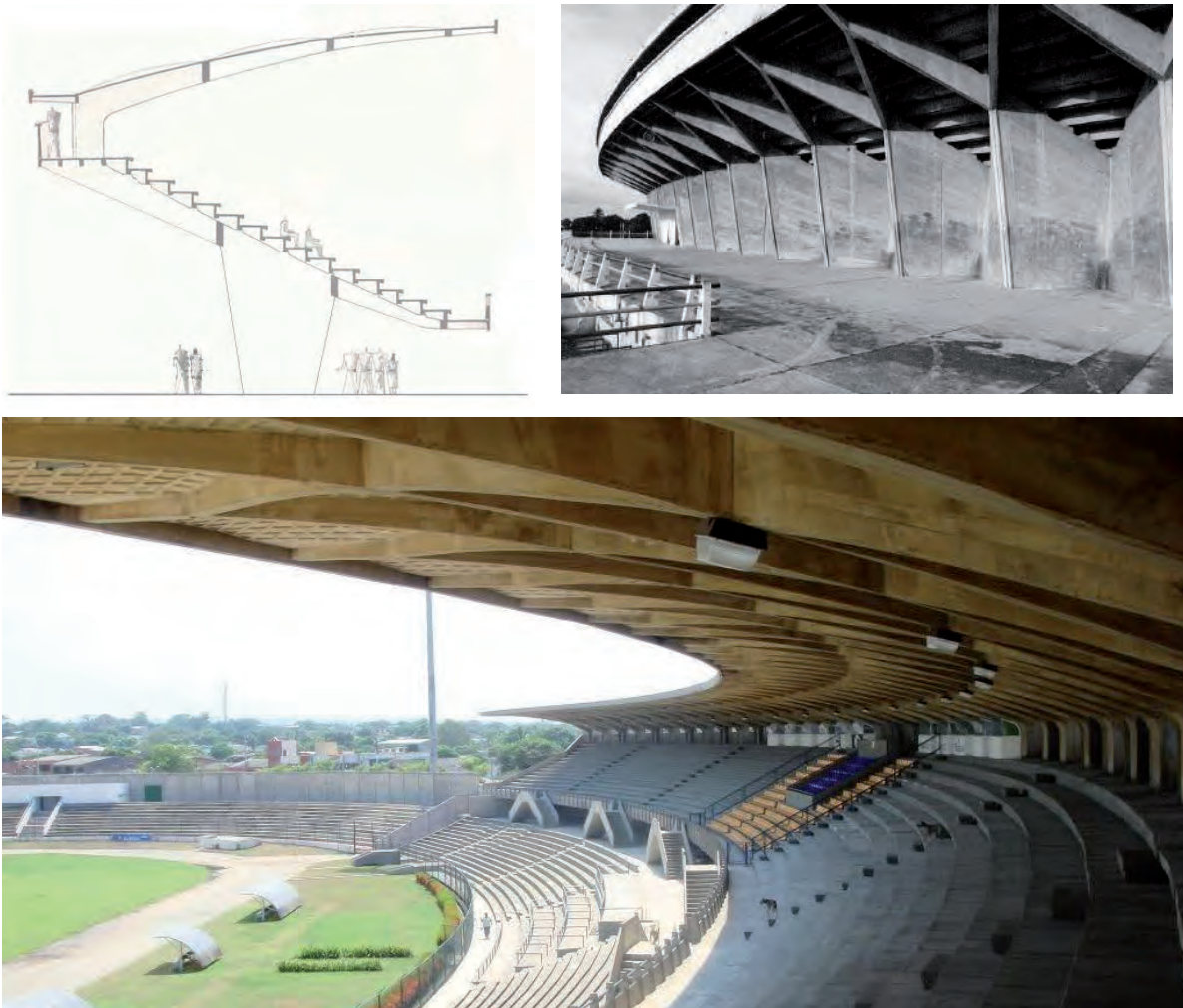
Imagen 238: Sección, estructura y cubierta en concreto a la vista de la gradería principal del estadio de fútbol Jaime Morón. Sistema de estructura en concreto a la vista que en forma de zigzag combina una geometría de vigas en diagonal que sustenta la gradería principal. Fuente: Archivo personal 2016.
