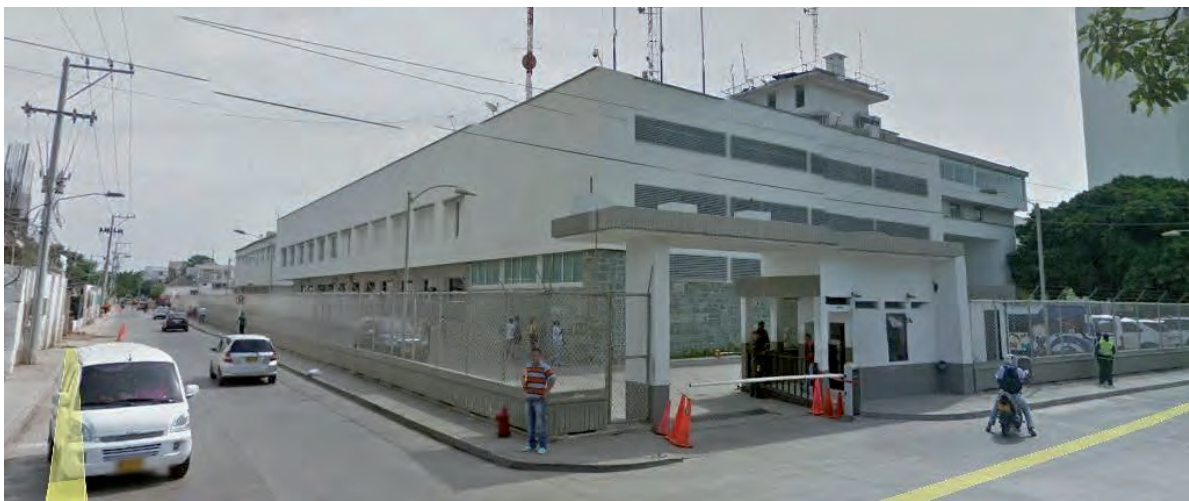
Imagen 162: Fachada principal y lateral del edificio sede de la Policía Metropolitana de la ciudad. En la primera imagen apreciamos el bloque administrativo y el volumen del lobby de acceso con su remate. La segunda fotografía ilustra el portal de acceso, el cerramiento, la textura de la piedra a nivel de la primera planta en el primer bloque y el ritmo de sus vanos, pérgolas, etc. Fuente: Google Earth, septiembre 2016.
