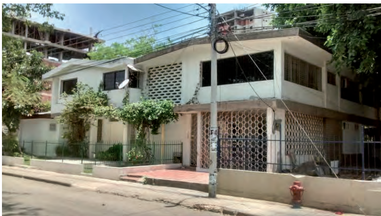
Imagen 143: Fachada callejón Lequerica de la casa del Dr. José Cabrera. Detalle de la zona de la escalera que a nivel de la segunda planta se ventila e ilumina a través de unos calados. Fuente: Archivo personal, 2016.
