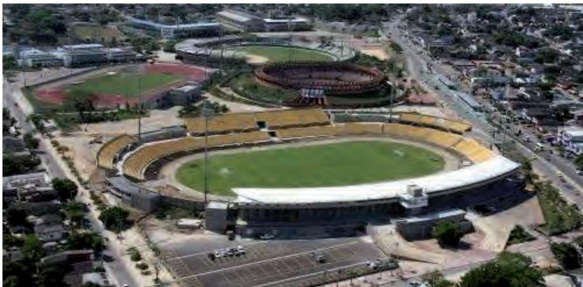
Imagen 381: Vista aérea estadio de fútbol “Jaime Morón”, se aprecia la cubierta de la tribuna occidental, la plataforma de servicios y las rampas de acceso. Fuente: Diario El Universal, 2011.
