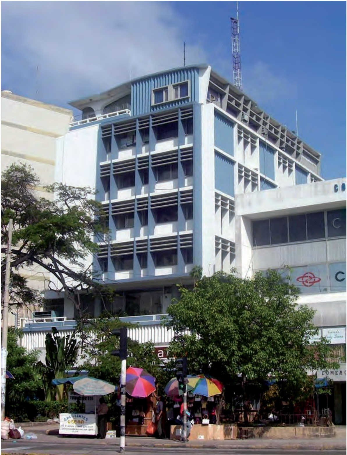
Imagen 2: Fachada principal del edificio Banco de Colombia, diseño del arquitecto cartagenero Rafael Cepeda Torres en La Matuna. Se observa el manejo bioclimático de la misma con corta soles y vanos retranqueados. Se destaca el remate ondulado de su cubierta, constituyendo en conjunto el lenguaje formal de su arquitectura. Fuente: Archivo personal, 2016.
