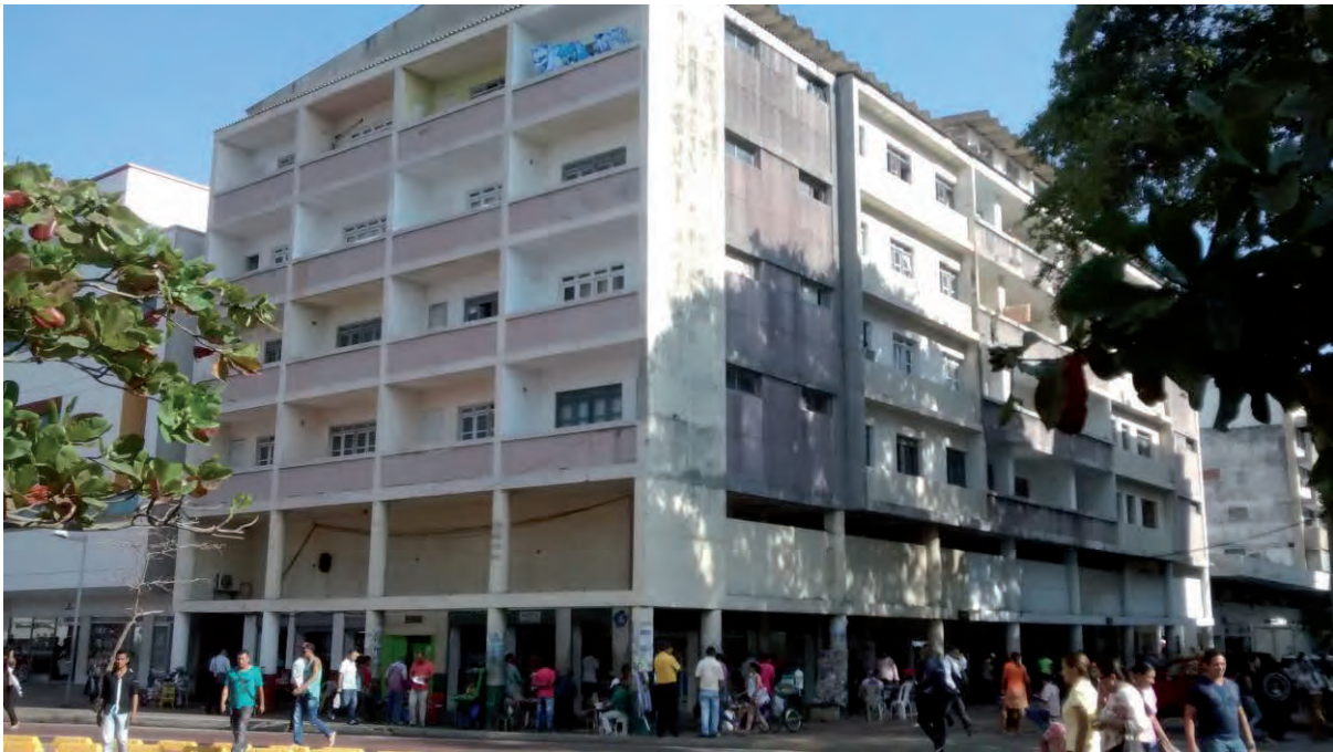
Imagen 24: Fachadas norte y este del edificio David, estado actual. Las pérgolas verticales de ambas fachadas han sido retiradas pro efectos de seguridad. Fuente: Archivo personal, 2016.
