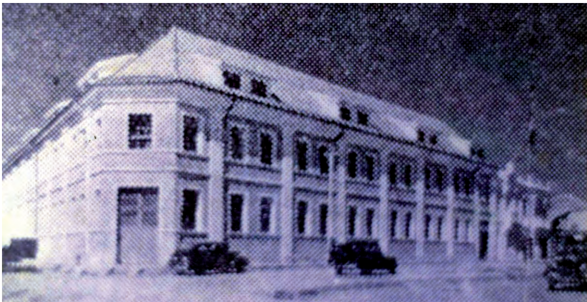
Imagen 48: Fachada principal Antiguo Edificio Talleres Mogollón, 1950. Fuente: Fototeca Histórica de Cartagena.
