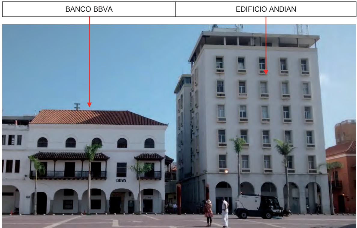
Imagen 26: Edificio Banco BBVA y edificio Andian. Fotografía de 2015 Fuente: Archivo personal.
