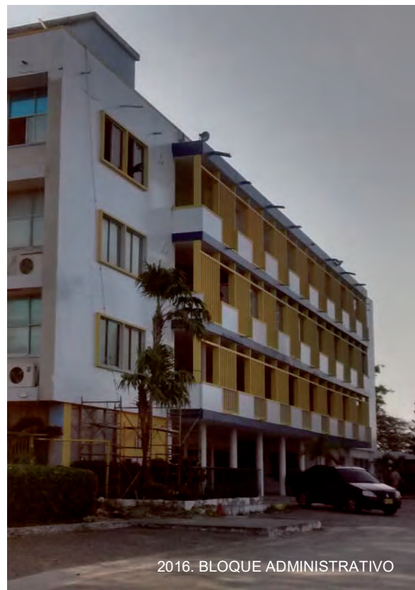
Imagen 283: Fotos fachada oeste bloque administrativo, detalles ampliados pérgolas verticales y portal de la primera planta, 2016. Se puede apreciar como el cuerpo central de la fachada principal del bloque administrativo sobresale de los planos laterales que lo flanquean en cada extremo, conformando una fachada falsa que protege los espacios útiles de la incidencia solar. Igualmente apreciamos en primera planta el portal que retranquea la fachada de las oficinas allí instaladas, a la vez que la fachada falsa se proyecta como alero sobre el portal. Fuente: Foto 2016, archivo personal.
