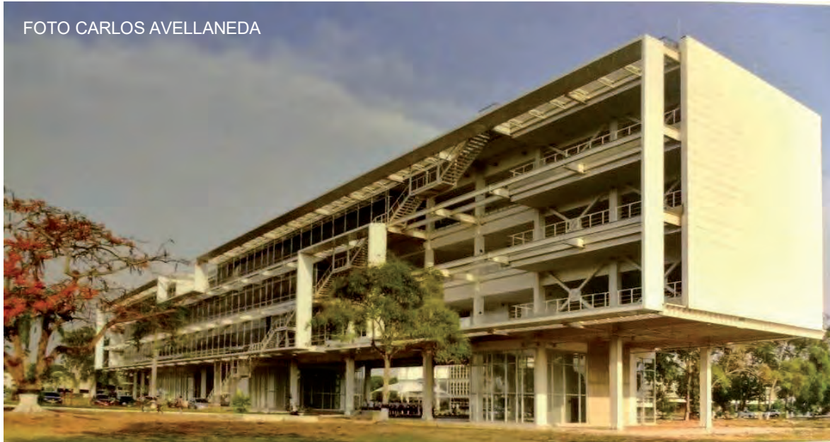
Imagen 352: Imágenes del edificio de aulas en las cuales se puede apreciar la aplicación de conceptos como la planta libre, los quiebra soles, fachada falsa, etc. Fuente: Renders 1 y 2 http://www.skyscrapercity.com/showthread.php?t=797934&page=941 consultad el 17-11-2016 y la foto final del edificio construido, tomada de panel de presentación del proyecto en la XXV Bienal Colombiana de Arquitectura, SCA, Cartagena de Indias, Septiembre de 2016 foto del arquitecto Carlos Alfonso Avellaneda.
