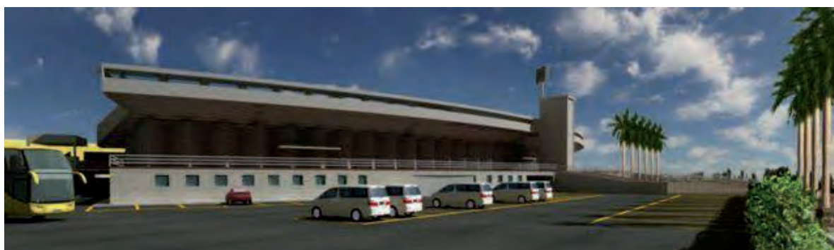
Imagen 399: Imagen renderizada del proyecto final de la tribuna occidental del estadio de fútbol “Jaime Morón”, se observa la plataforma básica, la torre de ascensores y el muro zigzagueante que soporta las graderías. Fuente: www.infodeportes.com/fútbol/estadioolimpicojaimemoroleon/ .
