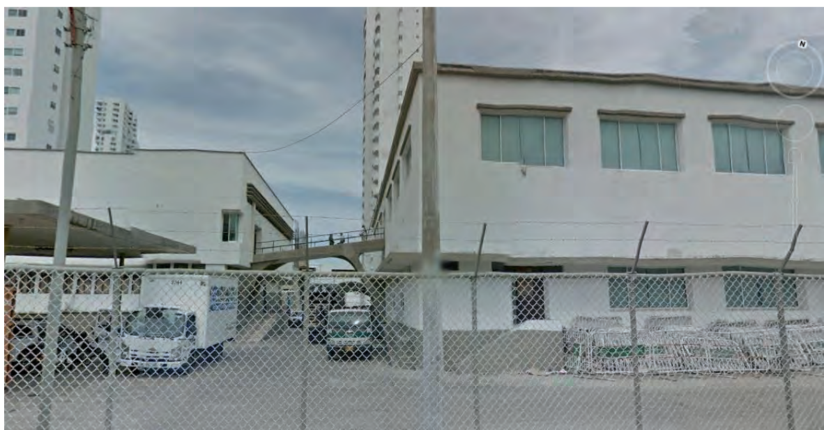
Imagen 163: Fachada posterior y lateral del edificio de la Policía Metropolitana de la ciudad. En la primera imagen apreciamos la parte posterior del bloque de fondo. Observamos como la segunda planta vuela perimetralmente sobre la primera, el ritmo de las ventanas y el zócalo a media altura sobre el muro del primer piso. La segunda fotografía muestra la conexión entre el primero y último bloque a través de un puente peatonal. Fuente: Google Earth, septiembre 2016.
