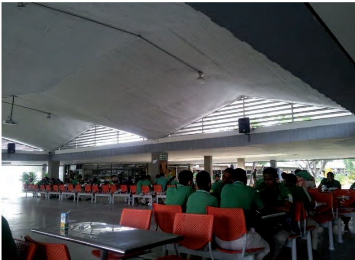
Imagen 323: Fotografías del área de cafetería. Se observa la condición del edificio abierto al espacio circundante – primer patio interior - y su cubierta paraboloid hiperbólico con ventilación superior. Fuente: Archivo personal 2015.
