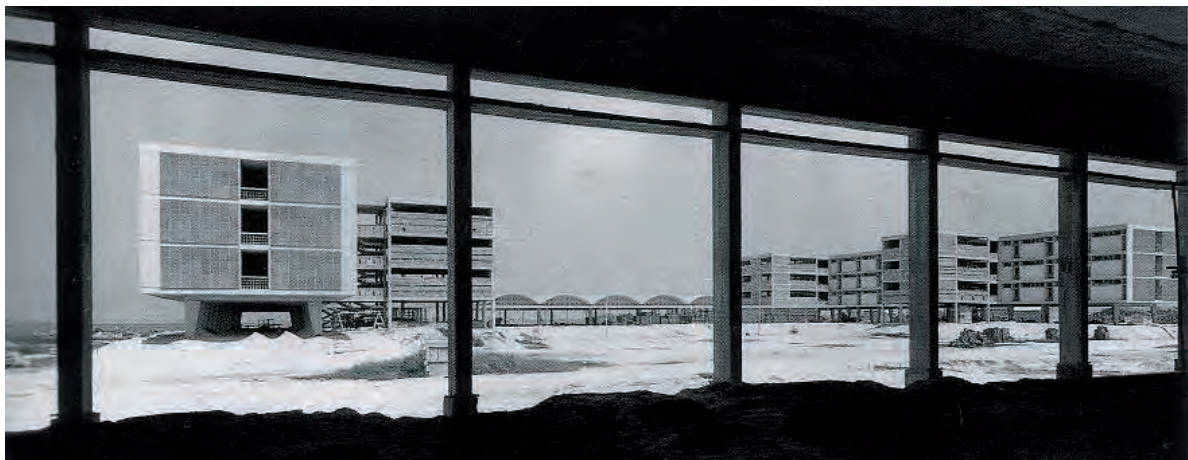
Imagen 242: Escuela Naval de Cadetes en construcción 1955. Se observa el concepto de planta libre usado en corredores tipo portal y en las primeras plantas de los edificios. Fuente: Eduardo Samper Martínez. “Arquitectura Moderna en Colombia”. Diego Samper Ediciones, Bogotá, Colombia, 2000.
