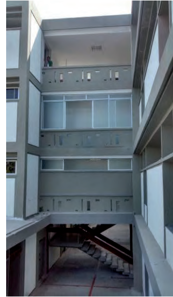
Imagen 332: Celosías empleadas en el área vestibular de los puntos fijos de las plantas del edificio de alojamientos, constituyendo parte de su envolvente. Fuente: Archivo personal, 31 - 01 – 2015.
