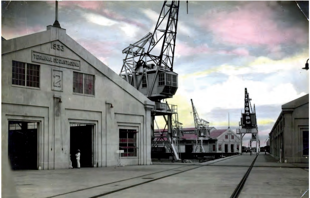
Imagen 157: 1936. Fotografía de la fachada principal de las bodegas del muelle y puerto marítimo y fluvial de Cartagena de Indias. Se observan en ellas el retranqueo de molduras que enmarcan los vanos, así como las pilastras, y en alto relieve el año de construcción, el nombre del terminal y el número de la bodega. Complementan el paisaje, las enormes grúas para carga. Fuente: Fototeca Histórica de Cartagena de Indias.
