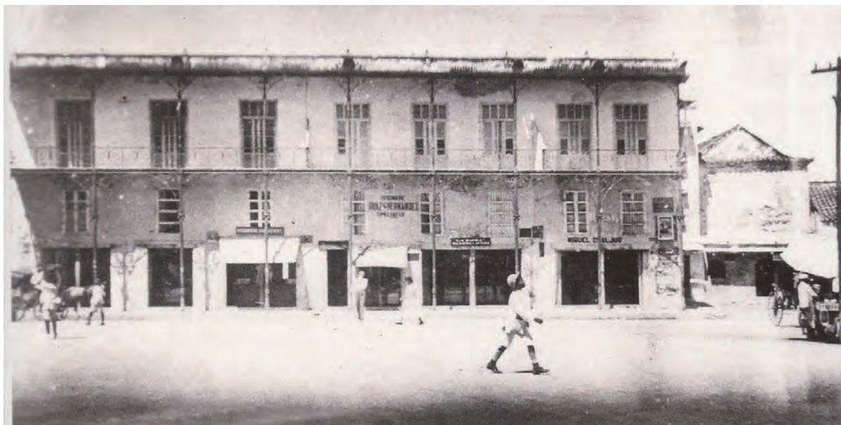
Imagen 27: Fotografía de 1920. Casa “Portal de hierro” en la Plaza de los Cochets construida para finales del siglo XIX (1895). Fuente: Fototeca Histórica de Cartagena.
