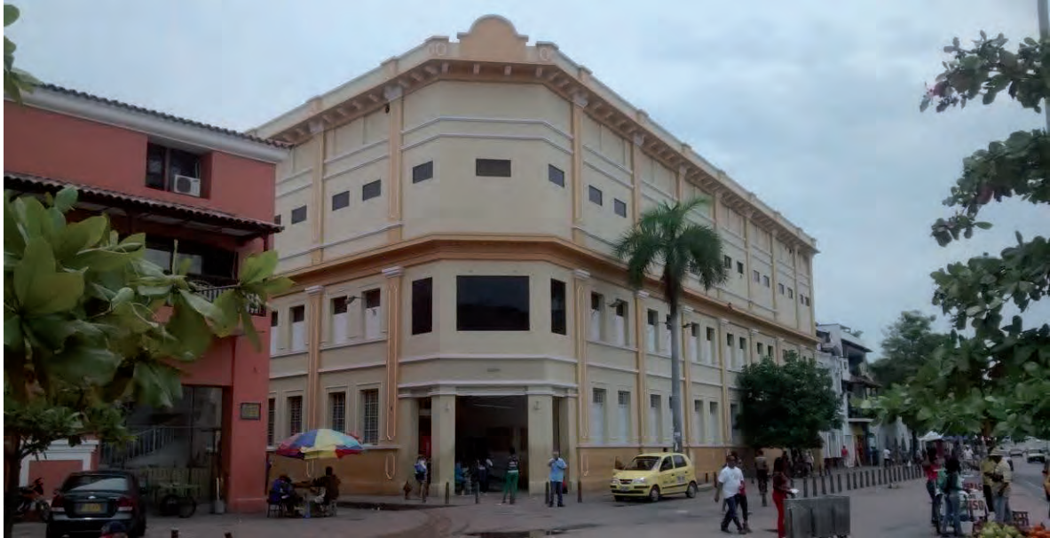
Imagen 36: Antigua Talleres Mogollón (1926), hoy almacenes Éxito: Diseñado por Nicolás Samer. Edificio de tres plantas destinado a uso comercial perteneciente a la cadena de Almacenes Éxito. Presenta acceso principal por vértice achatado en esquina, carente de ornamentación y en perfecta simetría compositiva, se constituye desde lo conceptual en la primera obra moderna de Cartagena de Indias. Fuente: Archivo personal, 2015.
