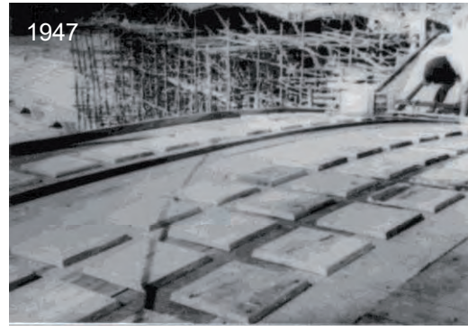
Imagen 212: Fotografía de la cubierta de la gradería principal del estadio de béisbol Once de Noviembre en Cartagena de Indias e imagen de su construcción con casetones. Fuente: Cubierta en 2016, archivo personal. Construcción de la cubierta, Fototeca Histórica de Cartagena, 1947.
