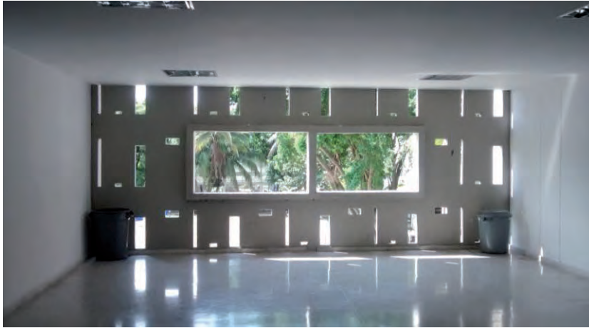
Imagen 332: Celosías empleadas en el área vestibular de los puntos fijos de las plantas del edificio de alojamientos, constituyendo parte de su envolvente. Fuente: Archivo personal, 31 - 01 – 2015.
