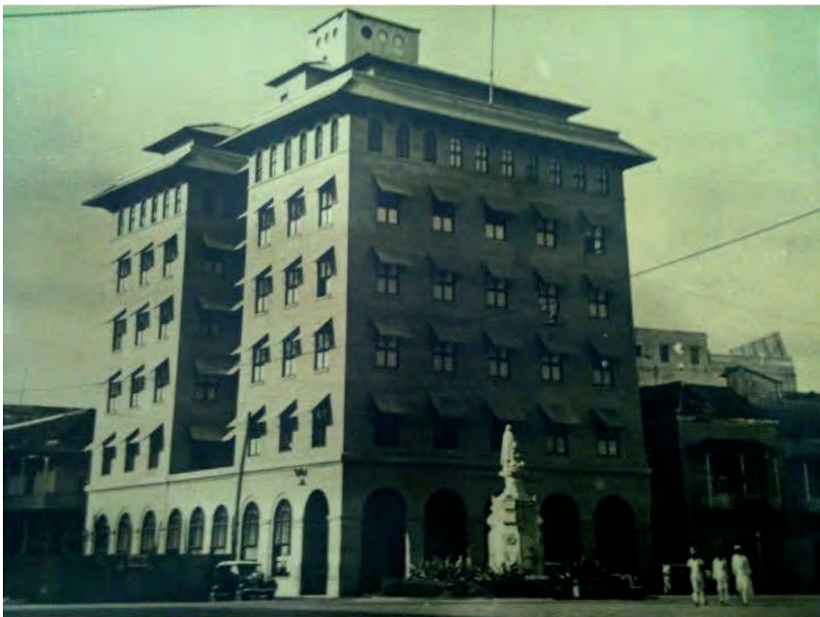
Imagen 49: 1938. Edificio Andian once años después de su construcción. Se observan las dos torres que lo constituyen. Como dato curioso, el edificio a nivel de la primera planta conservó el concepto del portal de la antigua casa de la “Isla”, el cual se reinterpreta y reutiliza integrándose a su arquitectura. Fuente: Fototeca Histórica de Cartagena de Indias.
