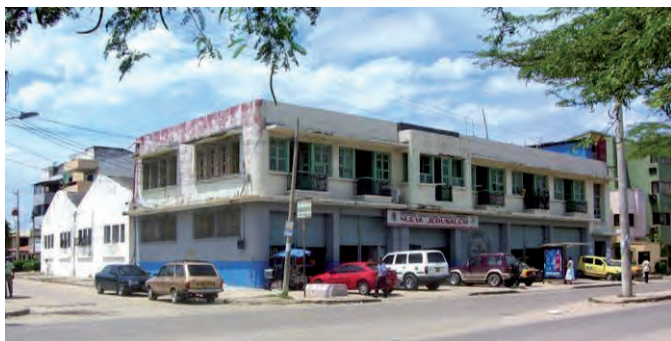
Imagen 130: 2005. Edificio Noel. Se aprecian sus características originales de grandes ventanales, balcones de hierro, simetría compositiva, eje jerárquico, etc. Fuente: Archivo personal.
