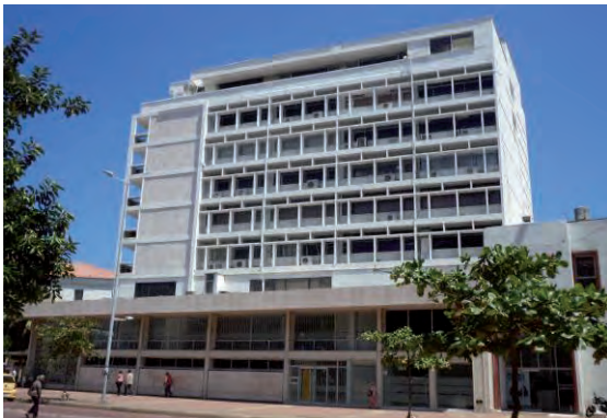
Imagen 226: Edificio Banco de Bogotá. Fachada falsa reticulada para protección del sol de la mañana implementada con quebra soles, corta soles, persianas verticales, retranqueos, etc. Fuente: Archivo personal 2016.
