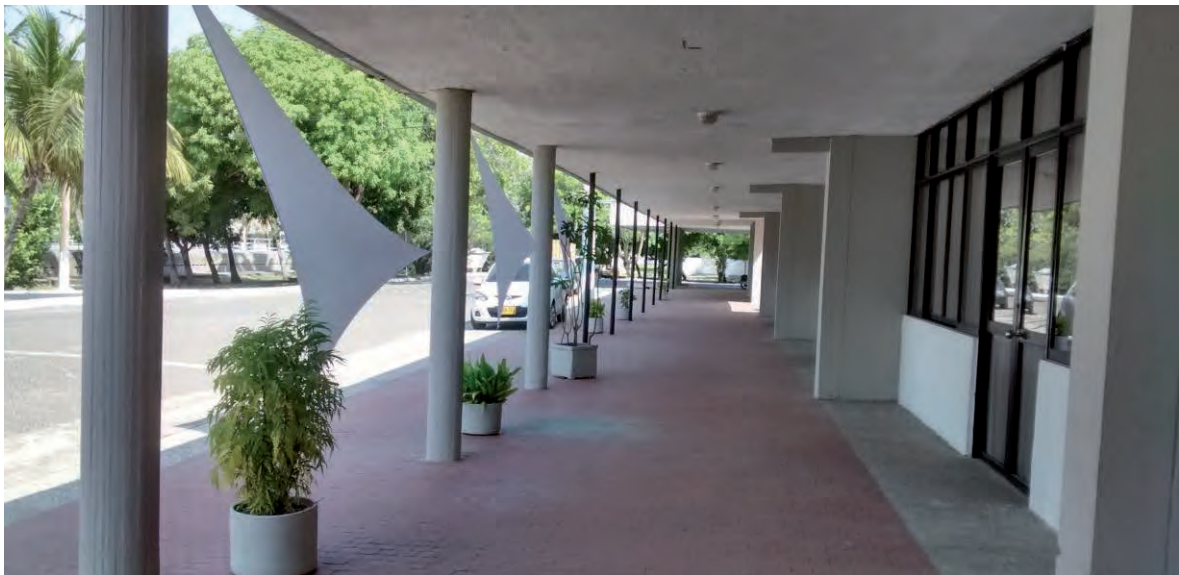
Imagen 333: Portal de la cámara de oficiales con cubierta plana. La cámara es el volumen cubierto con bóvedas de cañón. Fuente: Archivo personal, 31 - 01 – 2015.
