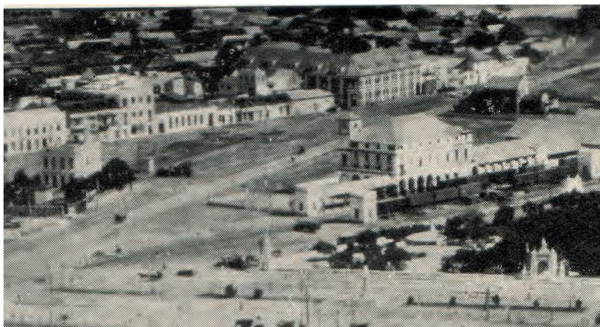
1926. c. Estación ferrocarril Cartagena – Calamar. Al fondo el Edificio Talleres Mogollón ya construido inicialmente en dos pisos.
