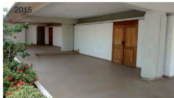
Imagen 334: Fotos de 1955 edificio de alojamientos donde se aprecia la planta libre hoy ocupada, el juego de pórticos de columnas, juego de caldos en fachada, etc. Fotos 2015 vigas acarteladas, portales y detalles de columnas como elemento estructural y estético que hace parte de la arquitectura de los edificios, en este caso del bloque de aulas. Fuente: Fotos 1955 Fototeca Histórica de Cartagena de Indias y fotos 2015, archivo personal.
