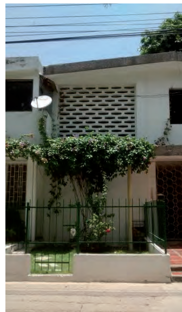
Imagen 143: Fachada callejón Lequerica de la casa del Dr. José Cabrera. Detalle de la zona de la escalera que a nivel de la segunda planta se ventila e ilumina a través de unos calados. Fuente: Archivo personal, 2016.
