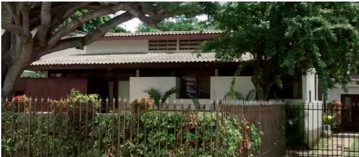
Imagen 167: Fachada principal de la casa No. 24 - 156. Se observa el amplio antejardín que antecede el paramento de su fachada y el juego de cubiertas de sus dos volúmenes, así como el manejo de los elementos formales y funcionales que la constituyen. Al fondo se aprecia el garaje de la casa que sirve de aislamiento con la casa vecina, la No. 24 - 146. Fuente: Archivo personal, octubre de 2016.
