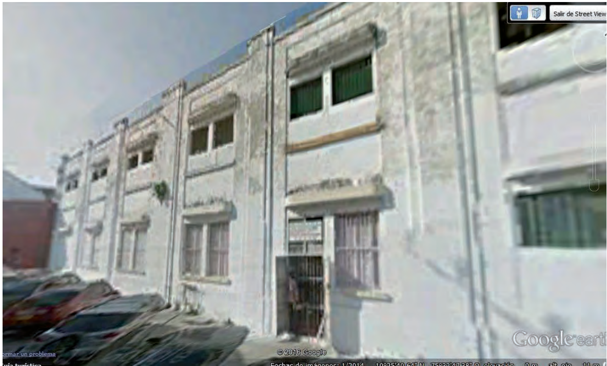
Imagen 77: Fotografía de la fachada principal de la Cárcel de Mujeres en San Diego, Centro Histórico de Cartagena de Indias, 2016. Fuente: Google Earth. Consultado el 12.12.2016.
