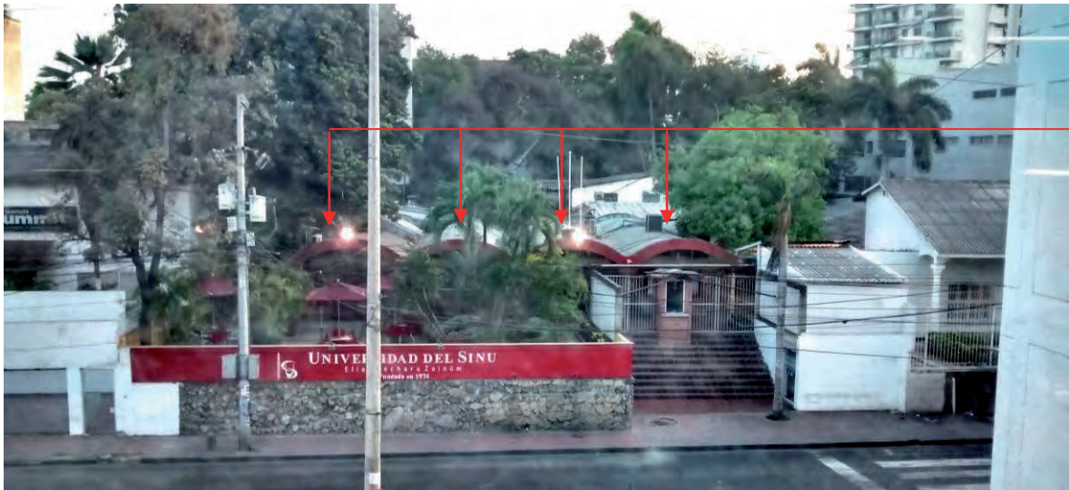
Imagen 140: Fachada Principal sede Universidad del Sinú. Localización e implantación general. Se observan las cuatro bóvedas de cañón que constituyen su cubierta. La edificación presenta un retranqueo general a nivel de paramento con una gran terraza social arborizada que da hacia la calle Real del Pie de la Popa. Un patio posterior, también arborizado, complementa el esquema bioclimático de la casa.
