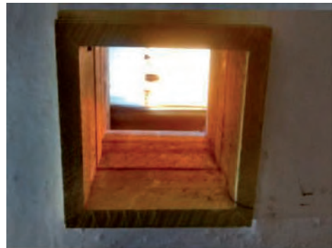
Imagen 307: Claraboyas rectangulares en la placa que cubre el segundo piso del bloque administrativo, localizadas sobre el área del pasillo de circulación de acceso a las oficinas. Fuente: Archivo personal 2016.
