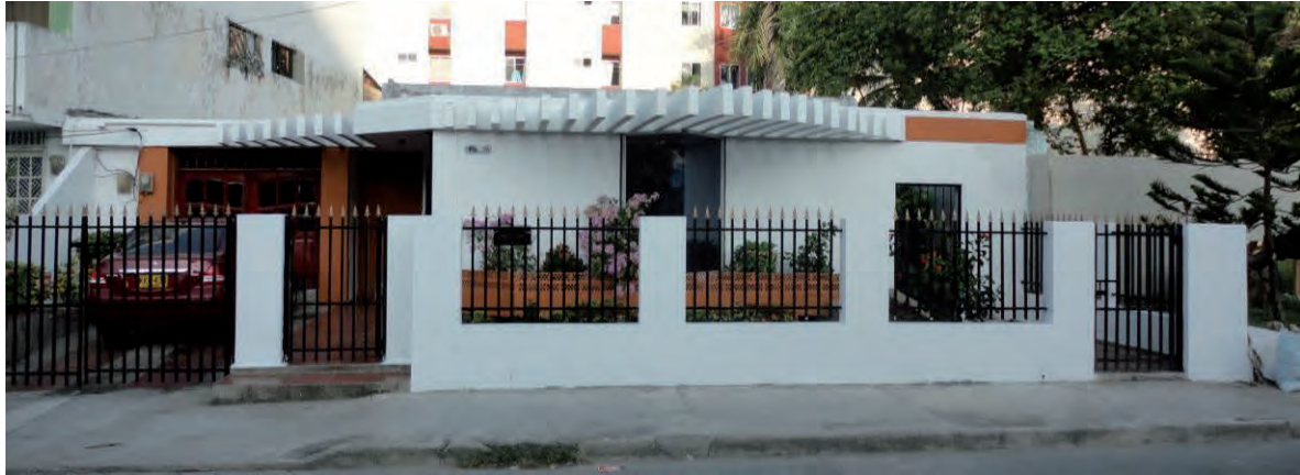
Imagen 133: 2016. Fachada principal casa Digeronimo sobre la carrera 21 D. Se observa en ella las pérgolas de concreto que controlan, mimetizan y direccionan la incidencia solar sobre los vanos de la misma. Fuente: Archivo personal
