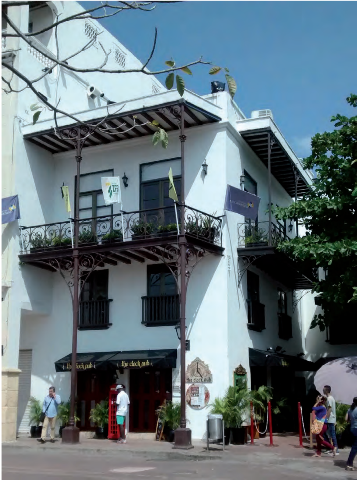
Imagen 31: Único vestigio de la Casa “Portal de hierro” en la Plaza de los Coches construida para finales del siglo XIX (1895) y único vestigio del modernismo en Cartagena. Fuente: Archivo personal.
