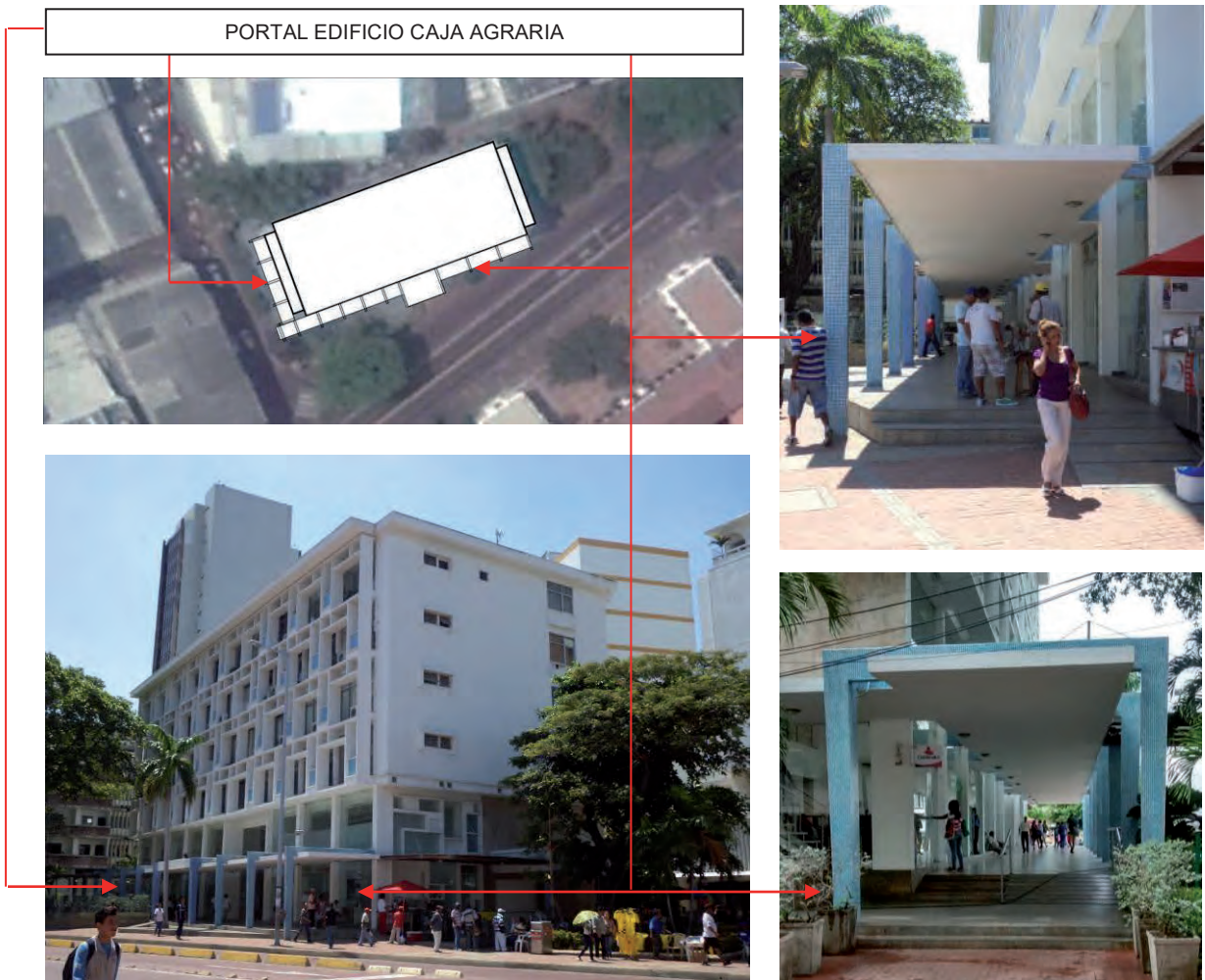
Imagen 227: Implantación edificio antigua Caja Agraria donde se observa el portal que lo circunda perimetralmente dos de sus cuatro fachadas y el beneficio que les presta a las personas que lo utilizan. Portal de excelente factura que se desprende del volumen del edificio como proyección de este hacia el espacio exterior. Fuente: Archivo personal, 2016.
