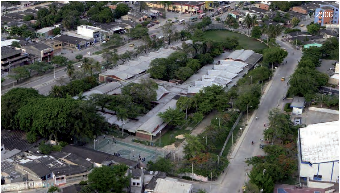
Imagen 320: Vista aérea del Sena que permite observar como el juego de cubiertas planas, abovedadas y de paraboloides hiperbólicas, armonizan generando una estética espacial en los espacios y volúmenes que cubren, donde el protagonista es el concreto a la vista. Fuente: Fotografía de Alexandre Magre Devesa, 2006.
