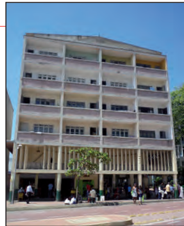
2016. EDIFICIO DAVID FACHADA PRINCIPAL SOBRE LA AVENIDA VENEZUELA.
