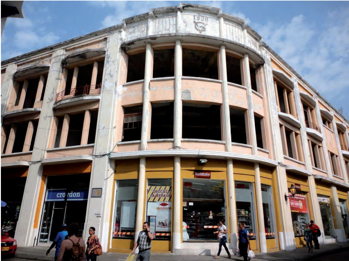
Imagen 82: Fachada principal edificio Vicente Gallo (1938) en la esquina de las calles Vicente García, Primera de Badillo, las Carretas y Tablón. Fuente: Archivo personal 2016.
