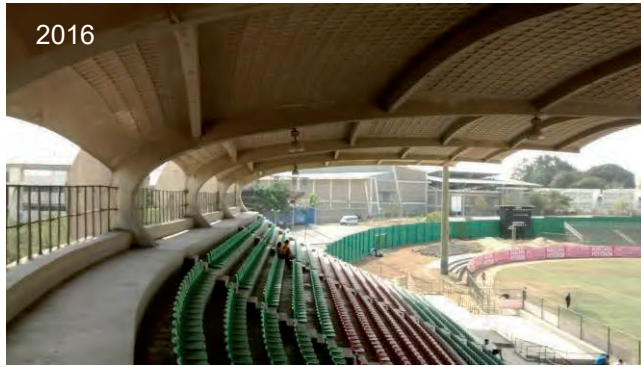
Imagen 212: Fotografía de la cubierta de la gradería principal del estadio de béisbol Once de Noviembre en Cartagena de Indias e imagen de su construcción con casetones. Fuente: Cubierta en 2016, archivo personal. Construcción de la cubierta, Fototeca Histórica de Cartagena, 1947.
