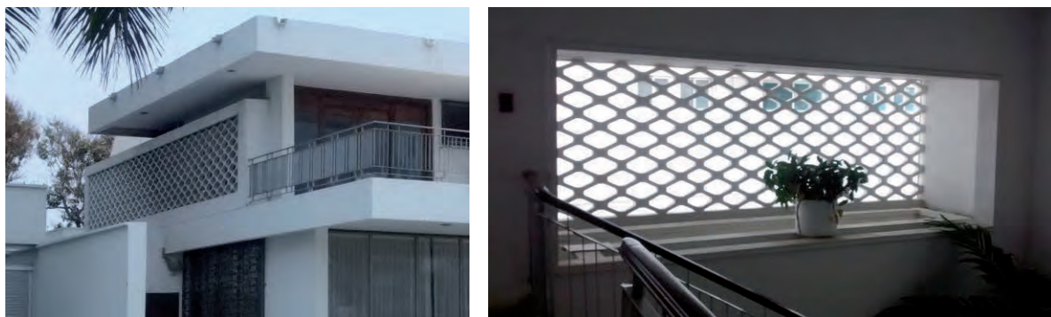
Imagen 237: Calados zona de la escalera y jardín interior casa Barbur en Castillogrande. Sistema de ventilación e iluminación natural de la casa Barbur conseguido a través de un conjunto de calados, localizados en la fachada lateral y en la parte posterior de la escalera y un jardín interior. Artificio estético y funcional. Fuente: Archivo personal 2016.
