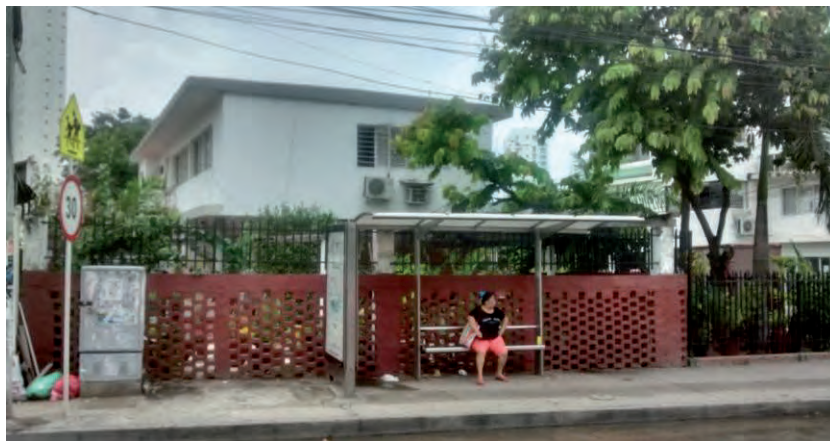
Imagen 170: Fachadas de la casa No. 25-154 (casa Aydee) sobre la Avenida Jiménez y sobre el callejón Román. Se observa el amplio antejardín que antecede el paramento de las mismas y el manejo de los vanos que mantienen la casa aireada y bien iluminada. Fuente: Archivo personal, octubre de 2016.
