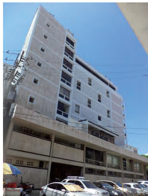
EDIF. BANCO DE BOGOTÁ FACHADA PROVISTAS DE CALADOS Y VANOS MODULADOS.
