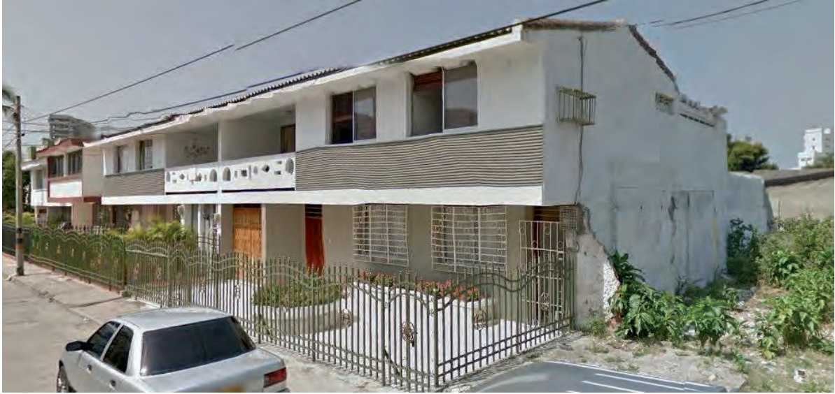
Imagen 151: Fachada principal de las casas gemelas en el año 2014. Aún la primera casa no había sido demolida. Fuente: Google Earth 2014.
