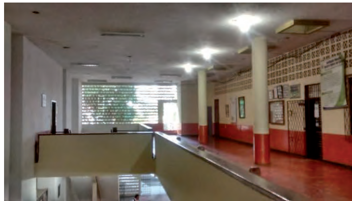
Imagen 307: Claraboyas rectangulares en la placa que cubre el segundo piso del bloque administrativo, localizadas sobre el área del pasillo de circulación de acceso a las oficinas. Fuente: Archivo personal 2016.
