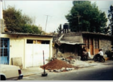
Figura 6. Vivienda sin consolidar, se observa materiales poco duraderos (Espinosa, 2000).
