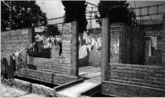
Figura 42. Casa en proceso de construcción y transformación. (Foto: Sergio Padilla Galicia).
