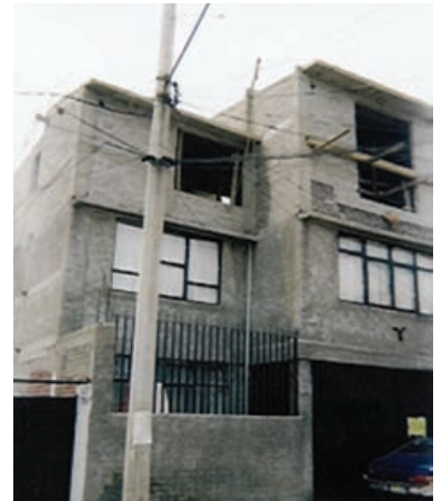
Figura 14. Vivienda en proceso de transición (Espinoza, 2000).
