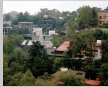
Figura 11. Viviendas residenciales en Bosques de la Lomas, al poniente de la ciudad de México. (Foto: Sergio Padilla Galicia)
