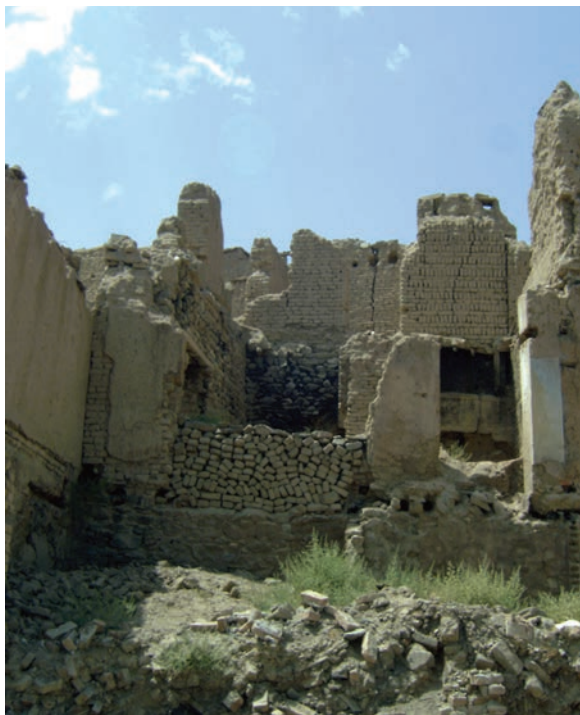
Figura 19. Pueblo destruido y abandonado.
