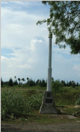
Figura 8 y 8a. Banda Aceh: columna 2,2 km de distancia del litoral que señala el nivel de agua (7 metros) en el mismo lugar causado por el Tsunami. (Foto: Ibid. ).
