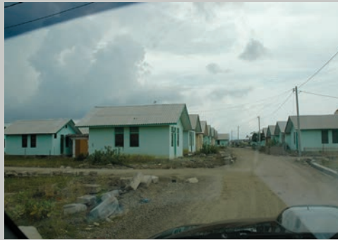
Figura 5. Banda Aceh: casas abandonadas. (Foto: Ibid. ).
