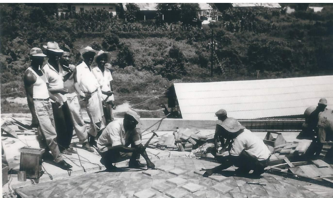
Imagen 17: 1947. Fotografías correspondientes a la elaboración de la formaleta en ceiba para la construcción de la cubierta de la gradería principal del estadio de béisbol. En la primera se observa el entramado que la soporta y en la segunda la colocación de pequeños casetones en “punta de diamante” para efectos de aligerar la delgada membrana abovedada de la cubierta en cantiléver. Fuente: Fotografías facilitadas por el ingeniero Jorge Rocha Rodríguez.
