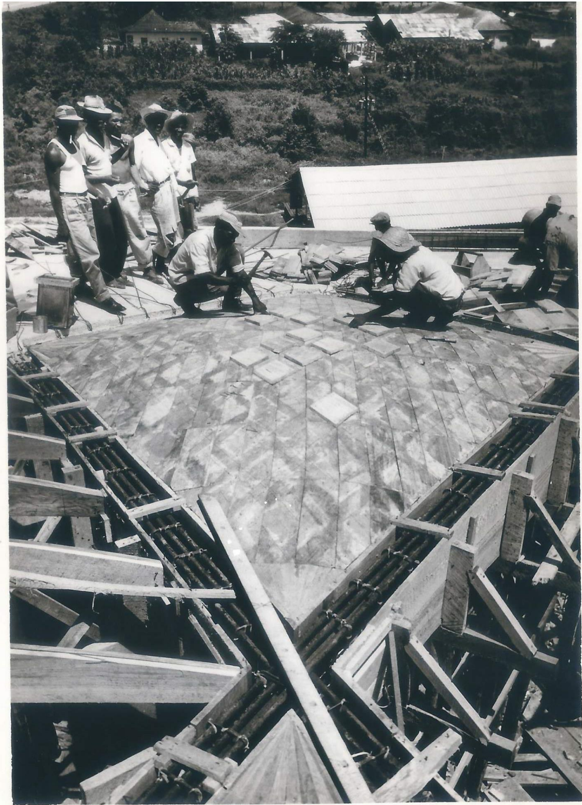
Imagen 18: 1947. Fotografía la formaleta para la construcción de la cubierta de la gradería principal del estadio de béisbol. Fuente: Fotografías facilitadas por el ingeniero Jorge Rocha Rodríguez.
