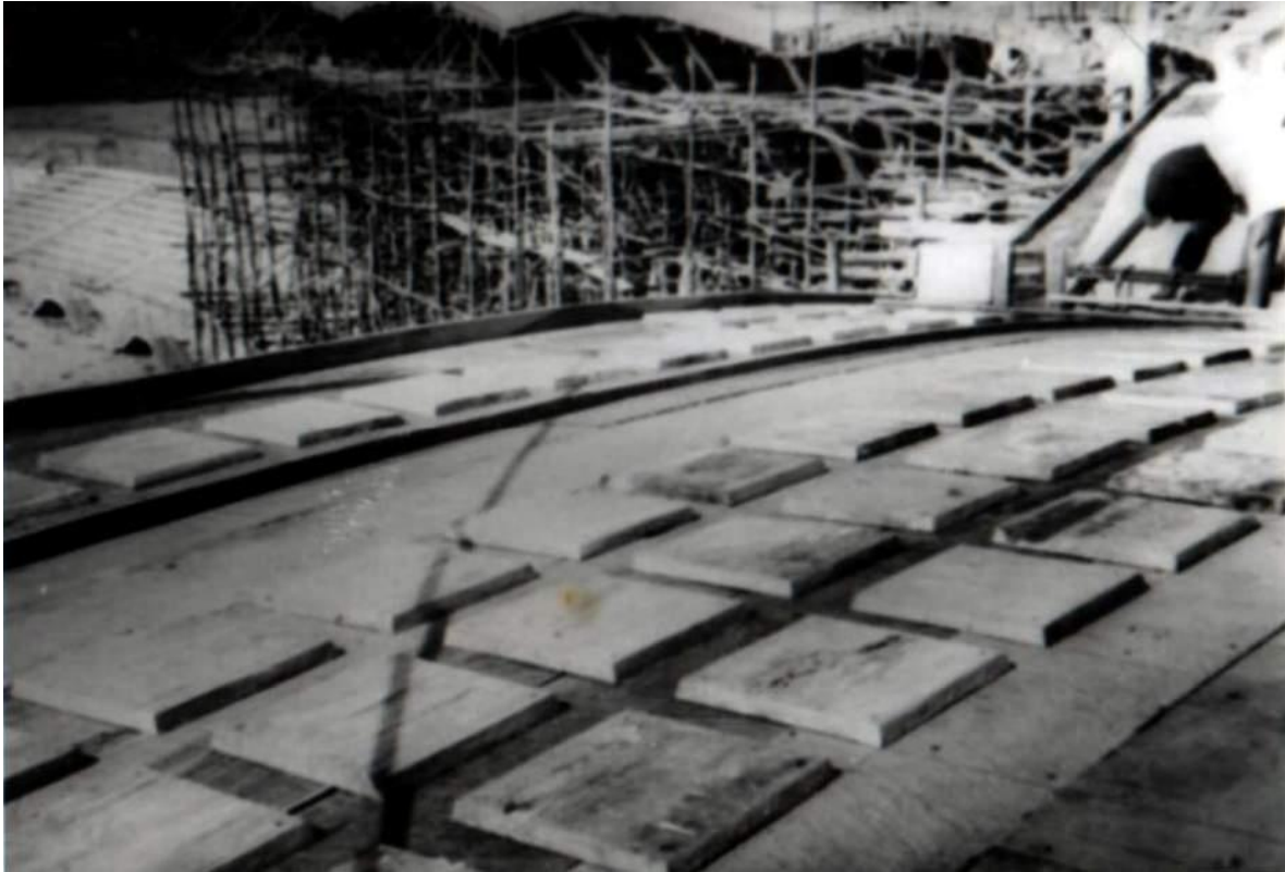
Imagen 15: 1947. Fotografía de la construcción de la cubierta de la gradería principal. Se observa en ella los pequeños casetones en forma de punta de diamante para aligerar la membrana de las bóvedas de la cubierta principal. Fuente: Fototeca Histórica de Cartagena.
