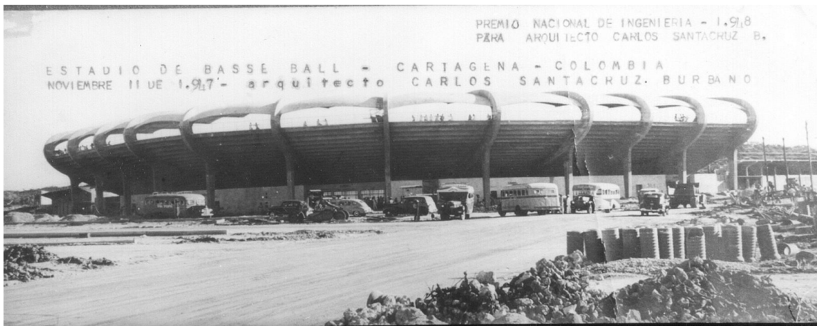
Imagen 16: 1947. Fotografía de la fachada principal del estadio "Once de Noviembre" donde se observan los doce pórticos que no solo sostiene las graderías y a la cubierta principal, sino que le dan carácter e identidad a la obra arquitectónica, hoy desafortunadamente perdidos en la intervención de 2006. Fuente: Fototeca Histórica de Cartagena.
