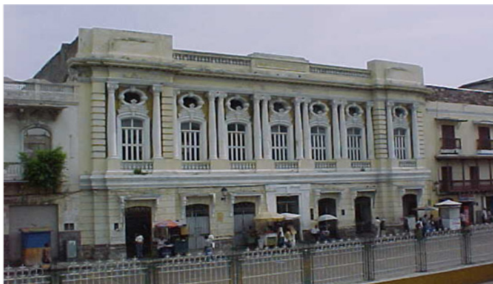
Imagen 59. Fachada principal del antiguo Club Cartagena en Getsemaní. Hoy en proceso de restauración haciendo parte del proyecto hotelero y turístico Four Seasons. Fuente: archivo personal de Ricardo Zabaleta Puello.
