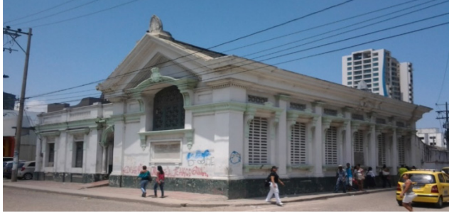
Imagen 61. Varias obras de Gastón Lelarge. Casa de Enrique Lecompte (sin uso actual), Escuela Municipal (sin uso actual) ambos BIC Distrital y Nacional, cúpula de la Iglesia de San Pedro Claver y Hotel Monterrey. Fuente: archivo personal.
