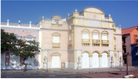
Imagen 37. Teatro Heredia, hoy Adolfo Mejía (1907- 1911). Arquitectura republicana por yuxtaposición. Edificio construido sobre los muros de la antigua iglesia de La Merced. Diseñado por el arquitecto empírico cartagenero Luis Felipe Jaspe Franco. Fuente: autor.
