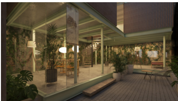
Figura 10: Casa Altamaria, vista de la crujía lateral izquierda y de fondo (2 pisos de altura), construidas totalmente en estructura metálica, vidrio y madera. Son la reinterpretación de la tipología original en la parte posterior del inmueble, respetando el espacio del patio el cual articula la nueva arquitectura con el núcleo básico de la casa colonial. Fuente: Estudio Colette, arquitectos: Cartagena de Indias, 2016.
