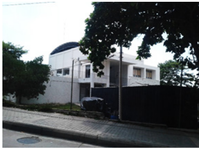
Figura 4: Fotografías de la edificación nueva que se acaba de construir como ampliación del edificio del Sena de los Cuatro Vientos y el cual afecta formal y visualmente la volumetría del edificio original, no siendo complemento de este. Fuente: Ricardo Zabaleta Puello, 2017.
