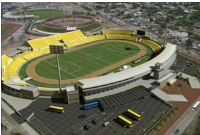
Figura 6: Vista aérea del estadio de fútbol "Jaime Morón" y su nueva propuesta. En la foto ampliada de la izquierda se nota la proximidad del volumen de una de las baterías de baño con relación a la cubierta. Fuente: Diario El Universal de Cartagena, año 2011.
