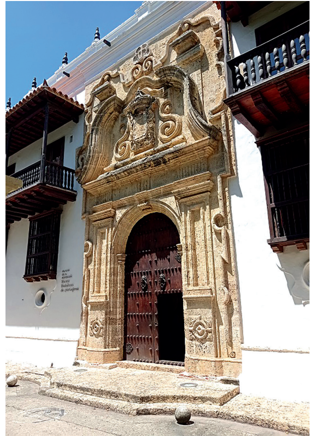
Fig. 3. Fachada Principal del Palacio de la Inquisición. Fotografía del autor. 2020.
