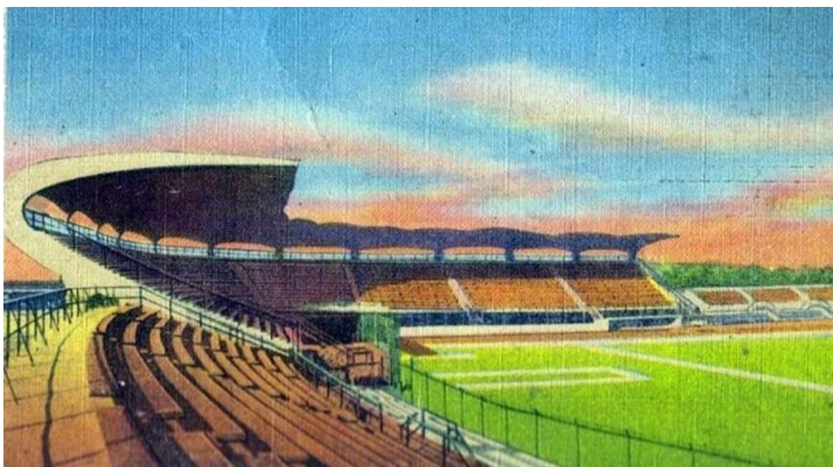
Imagen 6: Estadio de Béisbol “Once de Noviembre” de Cartagena, construido en 1947 para la conmemoración de la IX Serie Mundial de Béisbol Aficionado, de la cual resultó Campeón la selección Nacional de Colombia. Obsérvese el trabajo de su cubierta en cantiléver a través de 12 pórticos de concreto que grácilmente describen su arquitectura. Fuente: Archivo personal.
